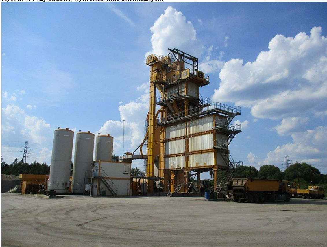
Rycina 1. Przykładowa wytwórnia mas bitumicznych.
